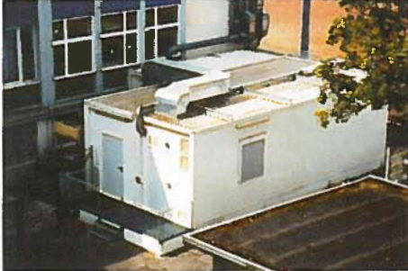
Reinraum-Container zur kostengünstigen Herstellung von Mikrostrukturen (mit 1/10 des Betriebsaufwandes üblicher Reinräume).
